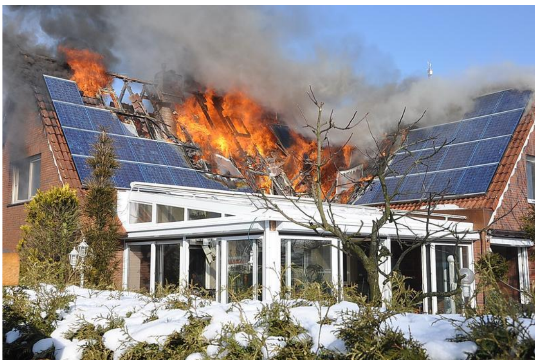
Stále ještě může být někde na střeše životu nebezpečné napětí.
