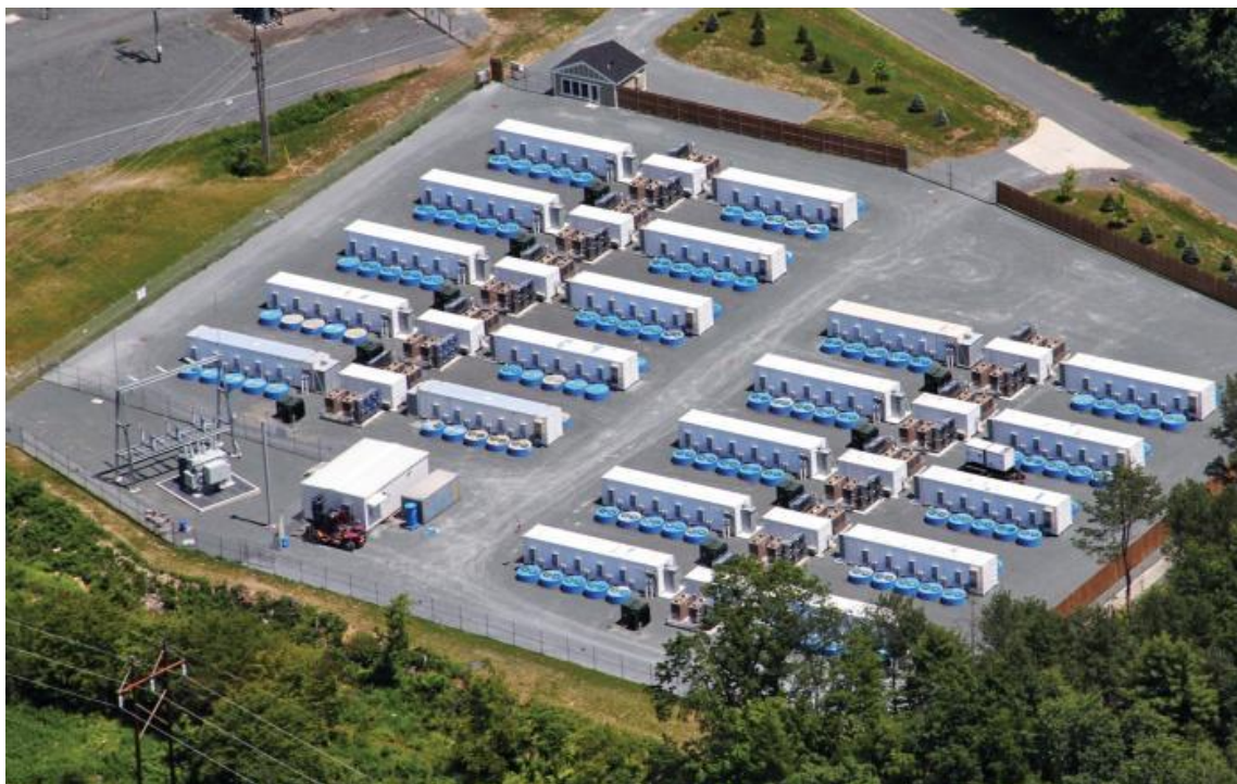
Příklad akumulace elektrické energie do setrvačných hmot.
