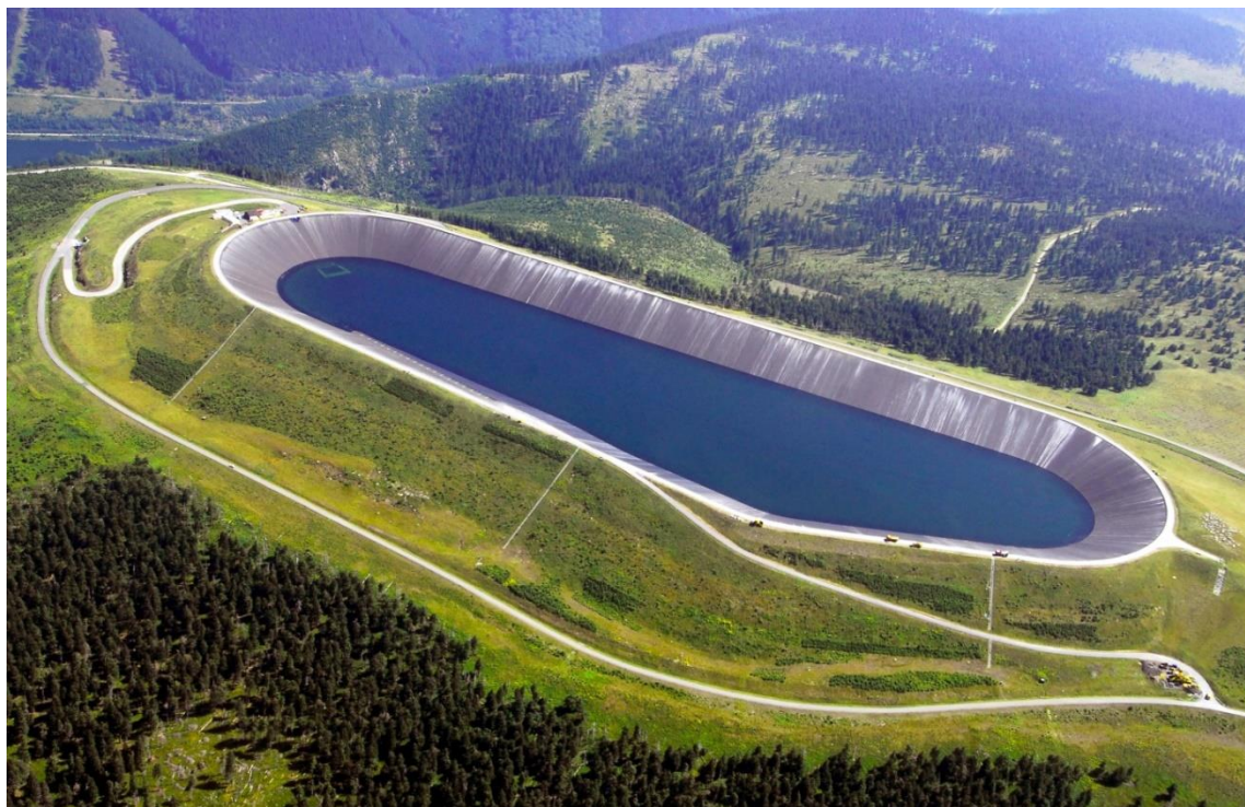
Jeden z příkladů použití technologie akumulace v praxi, přečerpávací vodní elektrárna Dlouhé Stráně.
